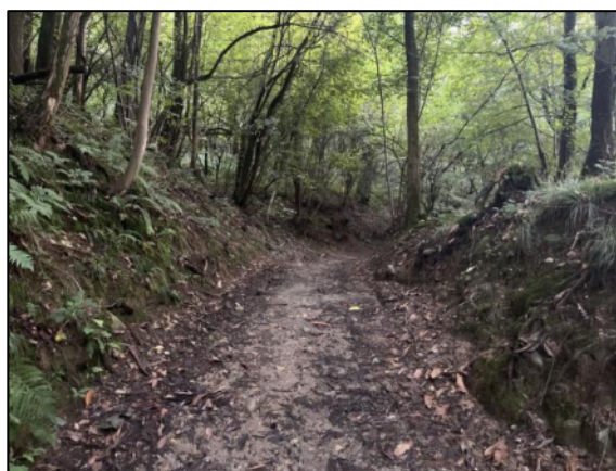
FOTO 6: RESTRINGIMENTO CARREGGIATA A 1,7 M
